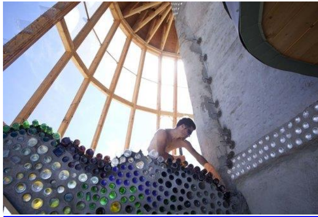
Obrázek 9 Earthship (stavba), Michael Reynolds
