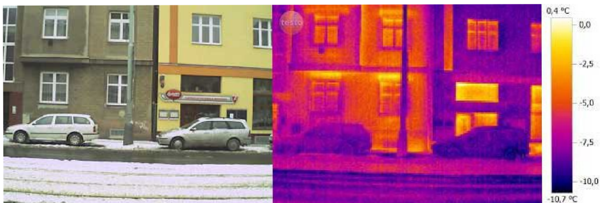
Obr. 4.1.2: Tepelné ztráty v důsledku špatné izolace (levá budova) a dobrá izolace bez tepelných ztrát (pravá budova) [3]
