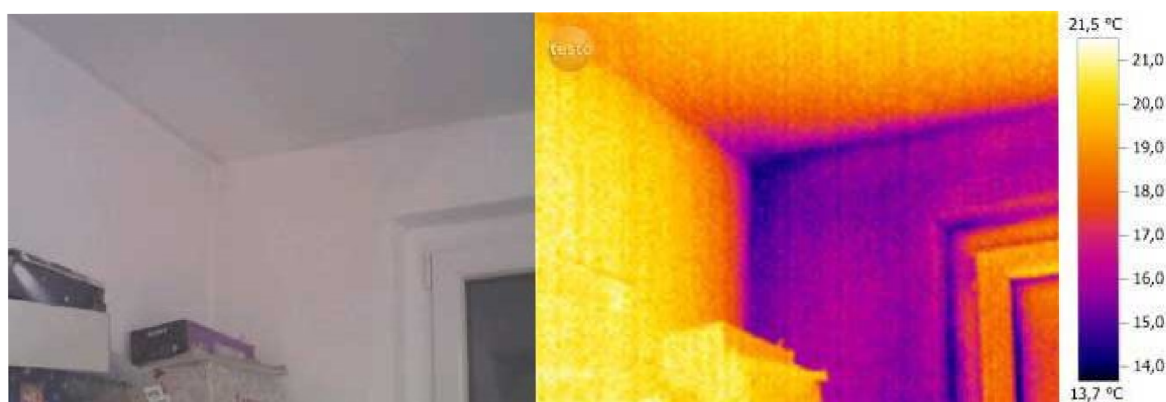
Obr. 4.1.3: Vnitřní pohled na tepelné ztráty [3]
