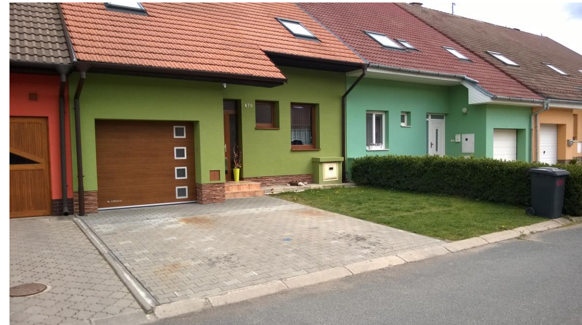
Obr. č. 35 Současný stav, ulice Komárov
