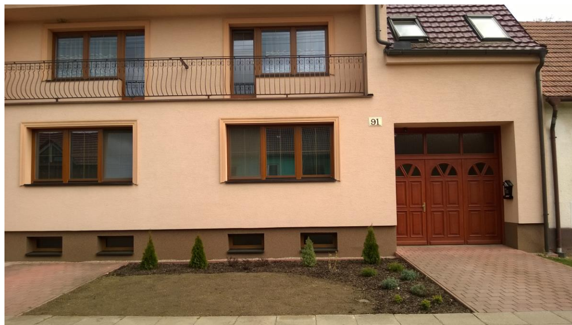
Obr. č. 30 Současný stav, ulice Rybáře
