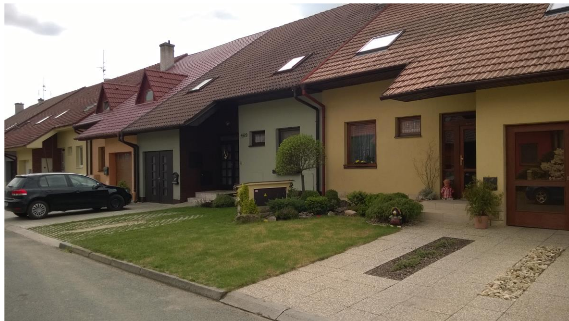
Obr. č. 34 Současný stav, ulice Komárov
