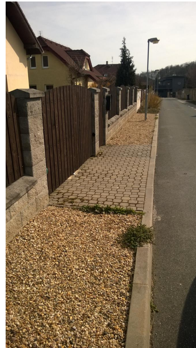
Obr. č. 51 Současný stav, ulice Nerudova
