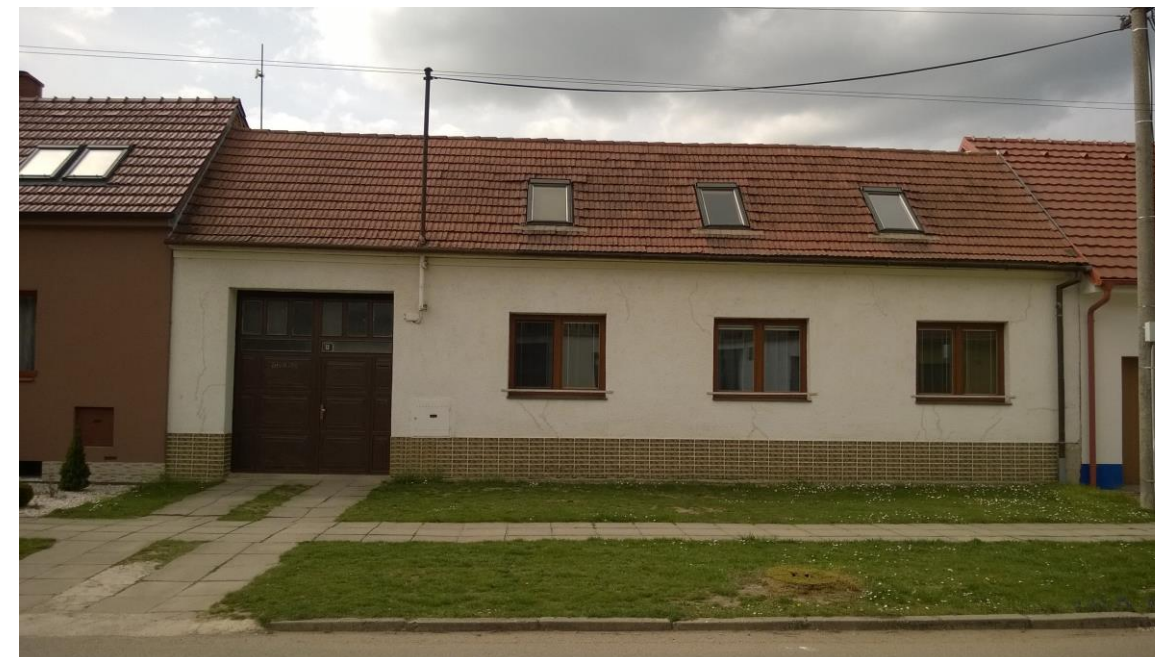
Obr. č. 29 Současný stav, ulice Rybáře
