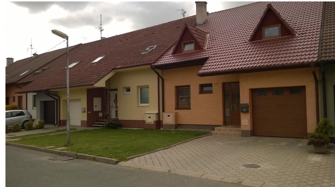
Obr. č. 33 Současný stav, ulice Komárov
