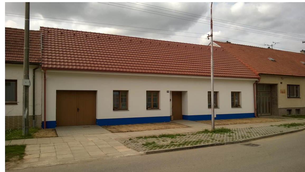
Obr. č. 31 Současný stav, ulice Rybáře
