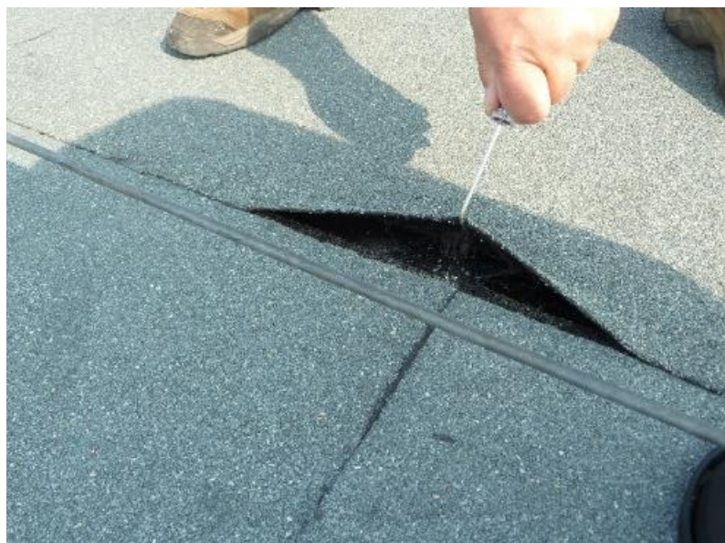
Obrázek č. 59: Jehlová zkouška hydroizolace
