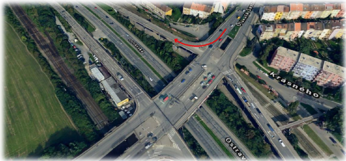
Obrázek č. 14: Bod č. 3 - Otakara Ševčíka x Ostravská
