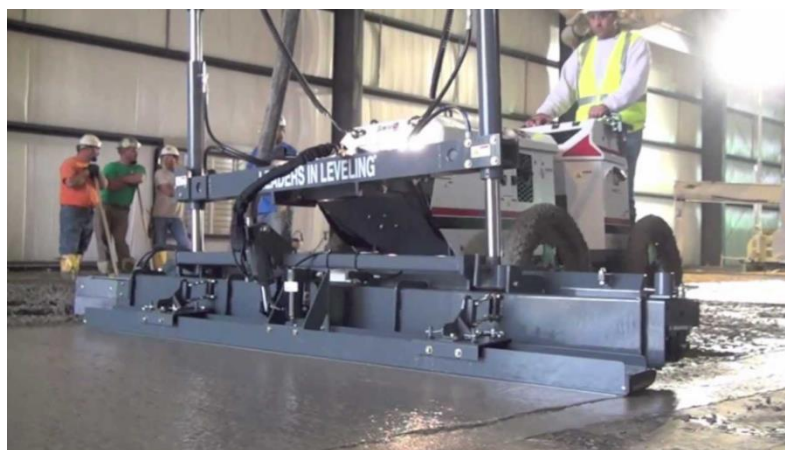
Obrázek č. 24 Hutnění a srovnání betonu
