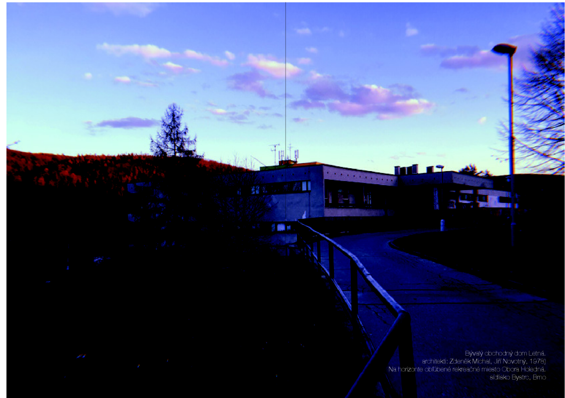
bývalý obchodný dom Letná v Bystrc
