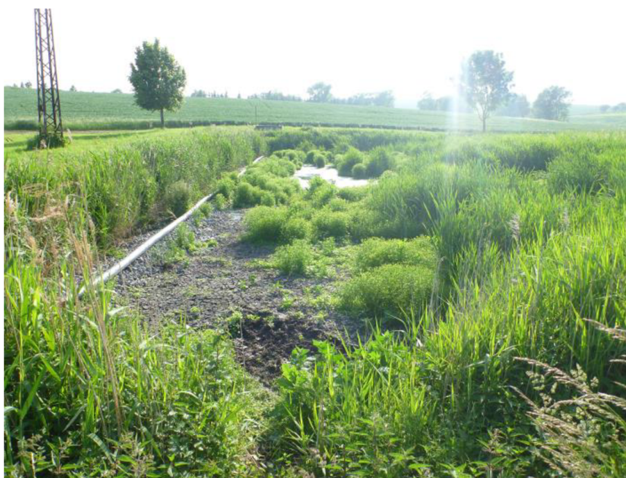
Obrázek 10: Pohled na kořenová pole KČOV v Dražovicích v roce 2014.
