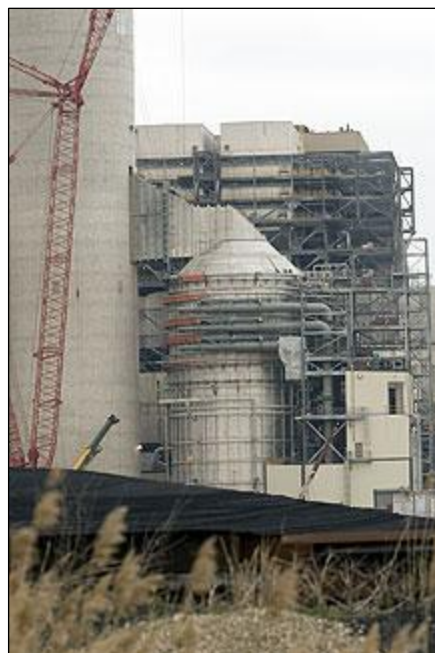
Obr. č. 7 Odsiřování spalin - systém WFGD [61]
