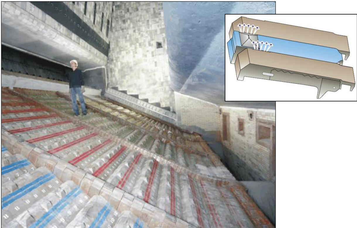
Obr. č. 5 Vratisuvný rošt firmy Martin GmbH für Umwelt- und Energietechnik a detail roštnice [39]
