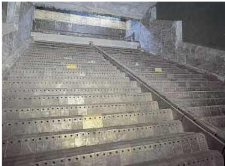
Obr. č. 4 Detail posuvného roštu firmy Von Roll Inova [68]
