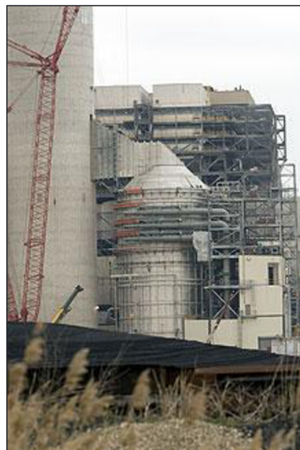
Obr. č. 7 Odsiřování spalin - systém WFGD [61]
