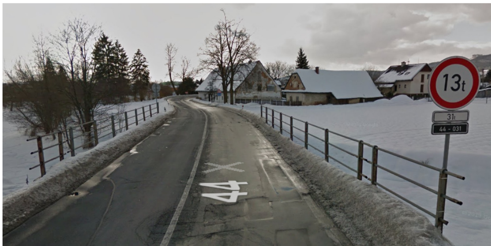
Obr. 2.6 – Mostek přes Losinku 44 - 031
