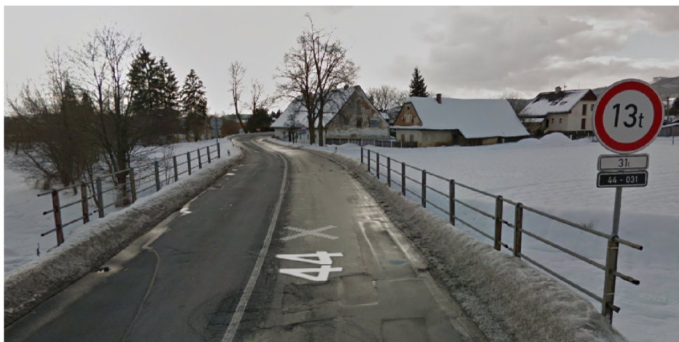
Obr. 2.6 – Mostek přes Losinku 44 - 031
