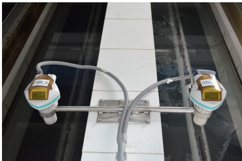
Obr. 9: Pohled na tlakové filtry s měřením hladiny ÚV HK 9
