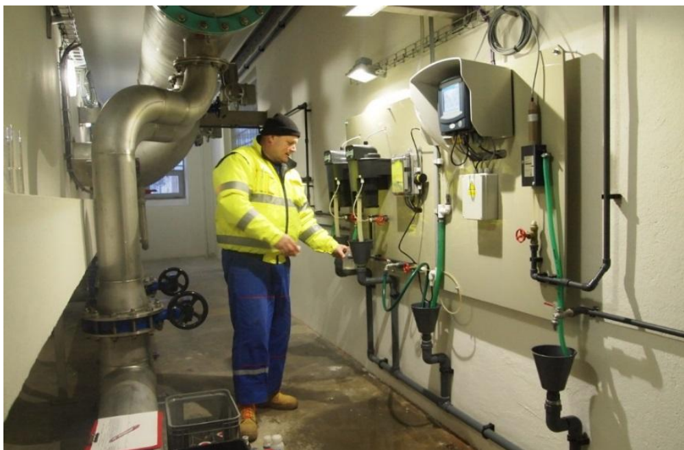
Obr. 10: Stálá provozní kontrola online analyzátorů, odebrání vzorků pro laboratorní rozbory kvality vody na ÚV HK 10
