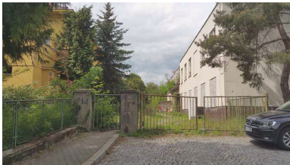
Vjazd na parcelu z ulice Roubalova
