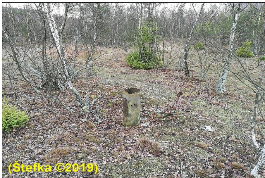
Obr. 14: Staré odkaliště - perforovaná pažnice z překližky
