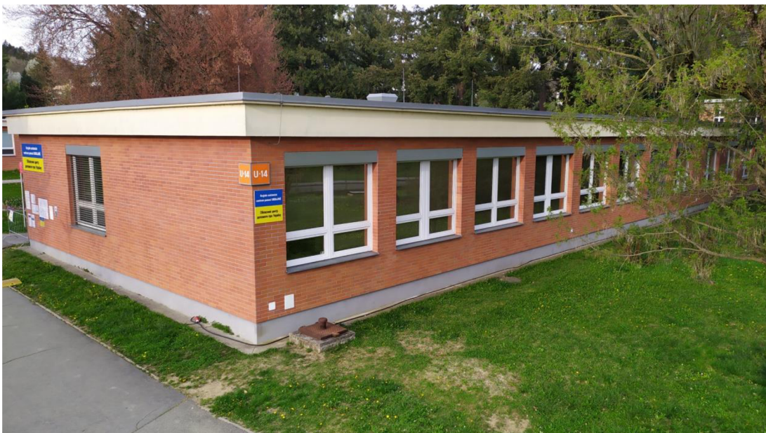
Obrázek č. 6 – Budova U 14 v krajské nemocnici Tomáše Bati ve Zlíně, kde bylo zbudováno KACPU Zlínského kraje. Zdroj: vlastní
