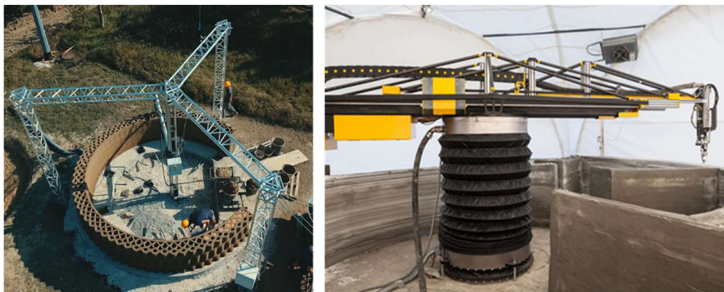
Obr. 3.7 Ukázka použití cylindrické kinematické struktury: firma WASP (vlevo) [17], firma Apis Cor (vpravo) [18]
