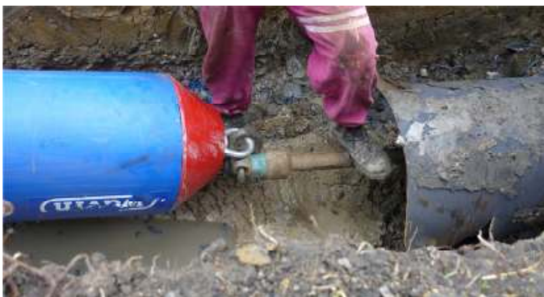
Obr. 2.9 Osazení plastového potrubí na konec rozbíjecí hlavy [17]
