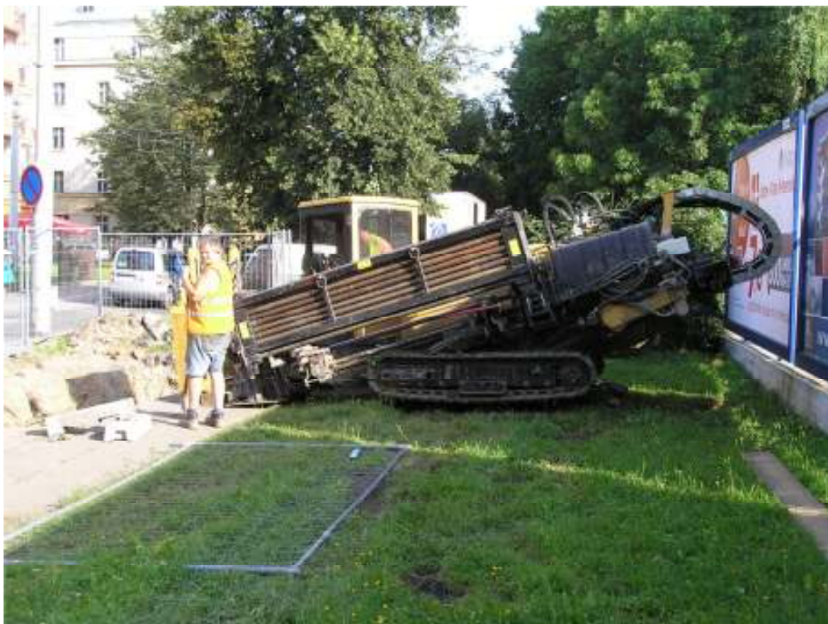
Obr. 2.5 Strojní sestava pro relining [17]
