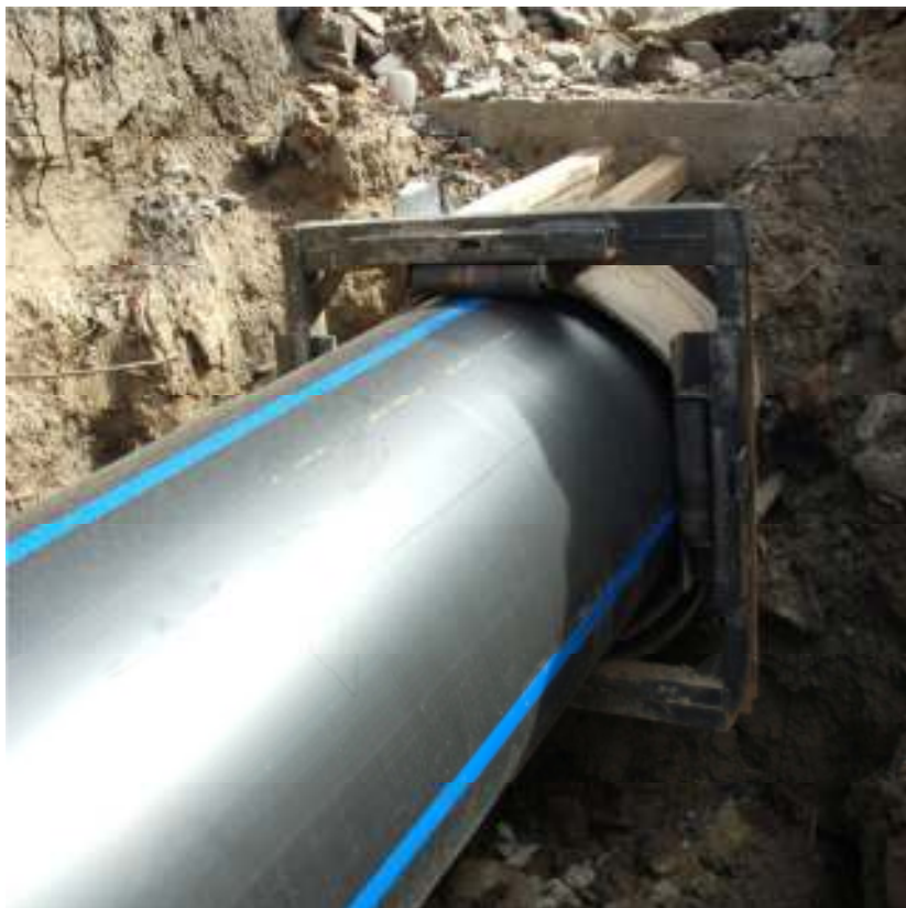
Obr. 2.7 Vtahování potrubí a zajištění jeho polohy [17]
