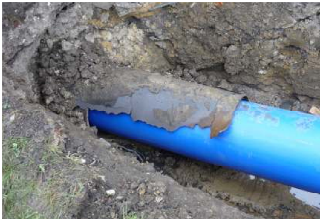
Obr. 2.10 Vtahování nového a rozbité staré potrubí [17]
