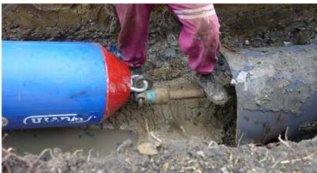
Obr. 2.9 Osazení plastového potrubí na konec rozbíjecí hlavy [17]
