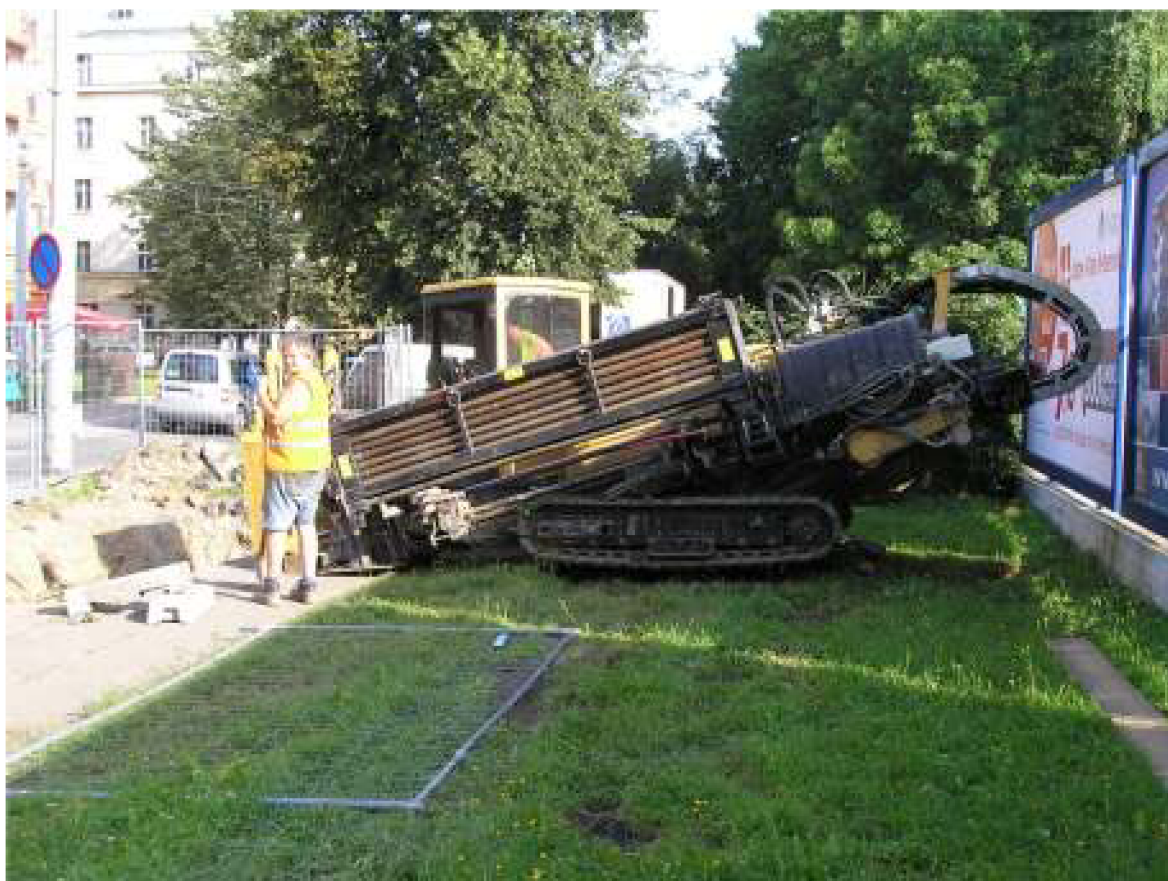
Obr. 2.5 Strojní sestava pro relining [17]
