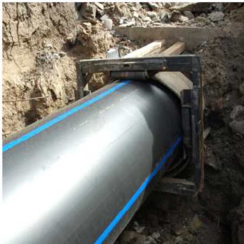
Obr. 2.7 Vtahování potrubí a zajištění jeho polohy [17]
