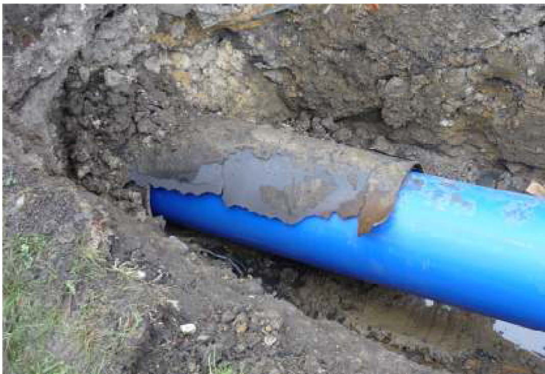
Obr. 2.10 Vtahování nového a rozbité staré potrubí [17]
