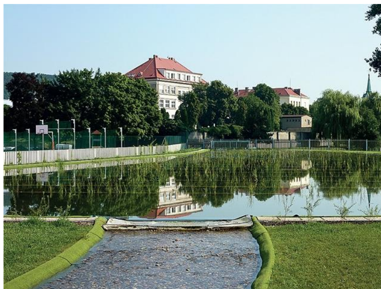
Obr. č. 3: Přítok čisté vody z regenerační zóny do užitkové (biotopradotin.cz)
