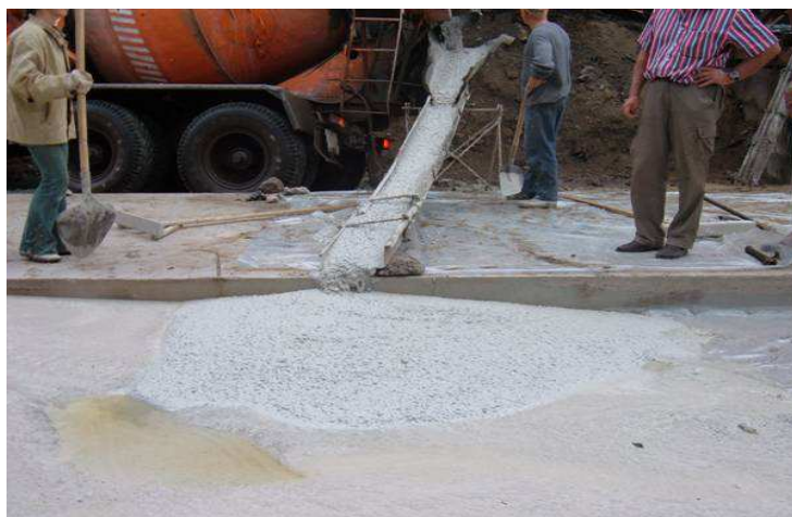
Obrázek 6 - AAM jako vyrovnávací vrstva silnic [2]
