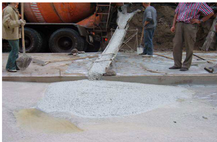
Obrázek 6 - AAM jako vyrovnávací vrstva silnic [2]
