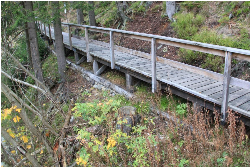
Obr. 11: Povalový chodník z rozměrově menších dílů u vodní nádrže v Peci pod Sněžkou. Foto autor
