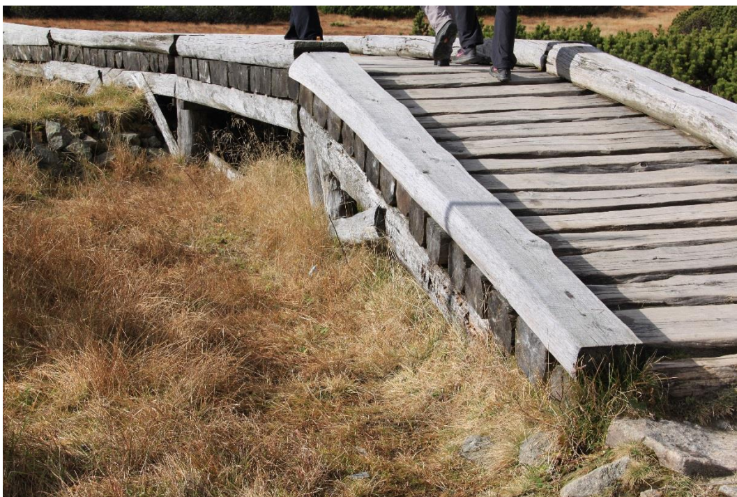
Obr. 10: Povalový chodník nad Úpským rašeliništěm. V popředí nástupní rampa, v pozadí jedna z opěrných zídek. Foto autor
