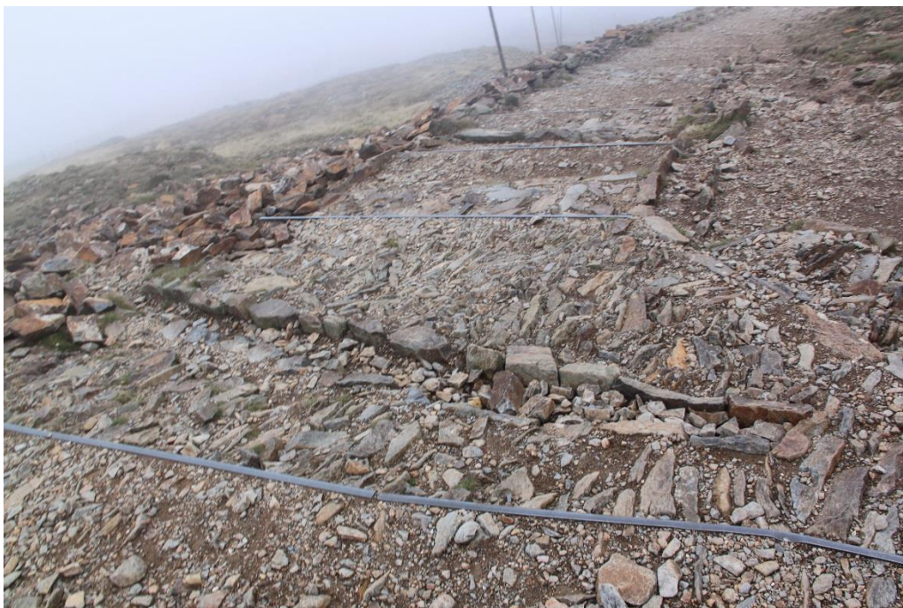
Obr. 5: Rozrušený a neudržovaný štětovaný chodník na jižním svahu těsně pod vrcholem Sněžky. Foto autor
