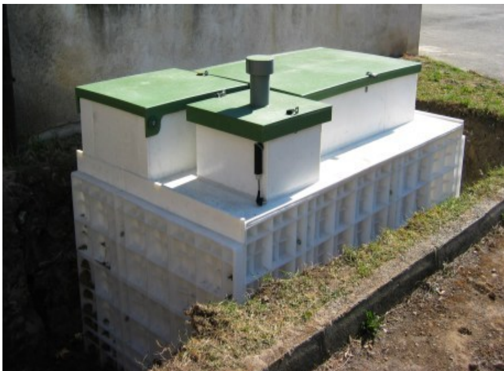
Příloha 4: Domovní čistírna odpadních vod - 20 EO
