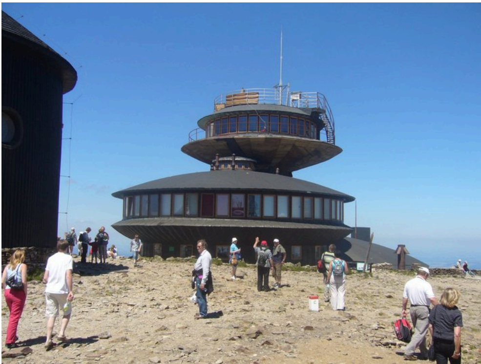
Obrázek 3 – Opravená Polská bouda v roce 2010
