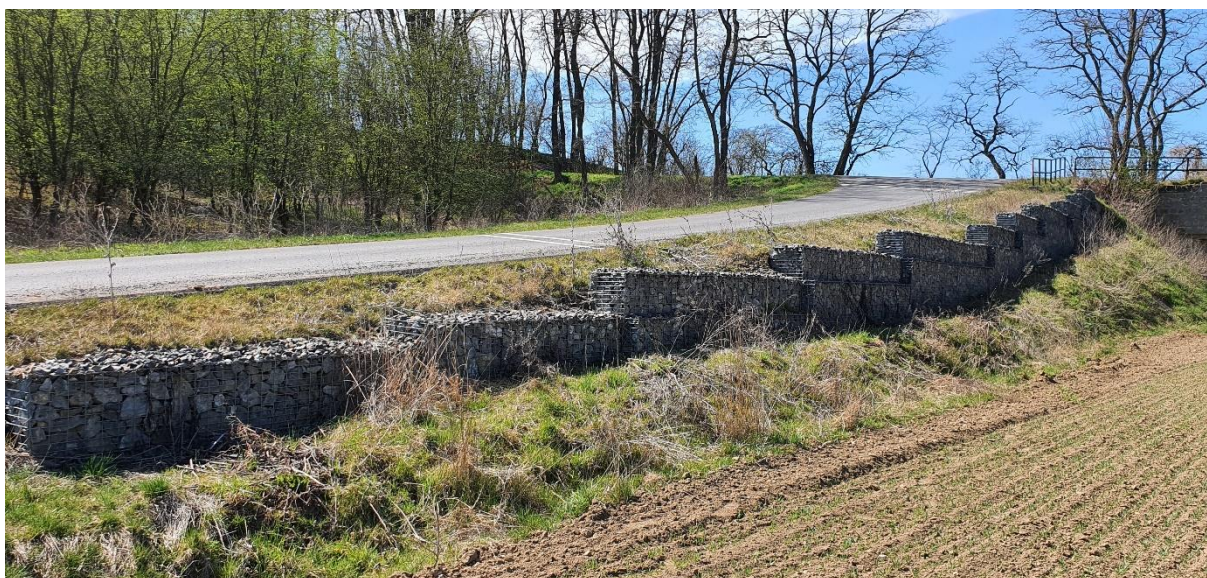
Příloha 5: Gabionová opěrná zeď u PC VC19, Vysoká u Mělníka, 2020 (vlastní)
