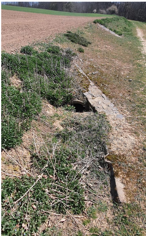
Příloha 12: Propustek pod sjezdem na pole zanesený zeminou, HC 4, Janova Ves 2020 (vlastní)
