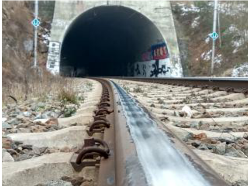
Obrázek 6: Skluzové vlny v daném úseku
