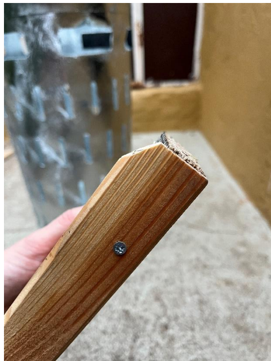
Příloha 6.: Lišta ze strany můstku je zkosená pro lepší zakotvení v kalovém koši.
