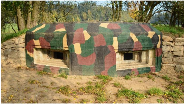
Abb. 6 heutiges Aussehen eines (auch vom Autor) restaurierten Objekts des „alten Modells“ in der Nähe von Neubistritz (eigenes Foto)
