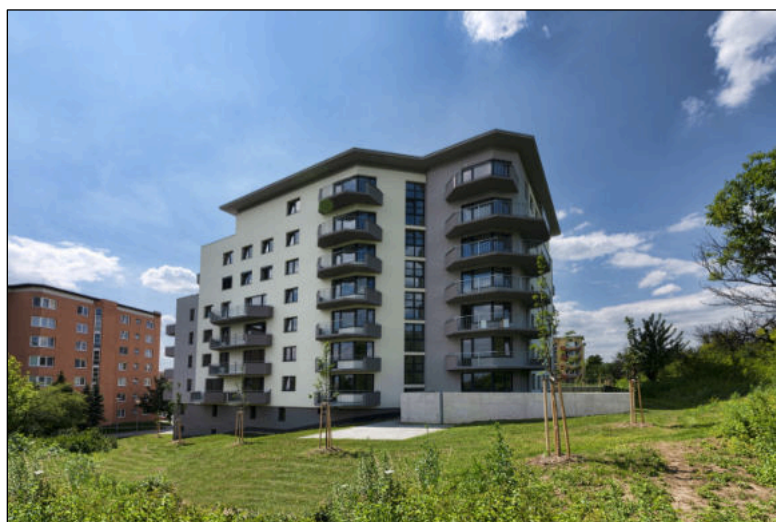
Obr. č. 52 - Bytový dům Julec [59]
