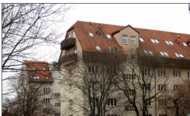
Obr. č. 43 - Nástavba na panelovém domě typu B60 v Juliánově [47]
