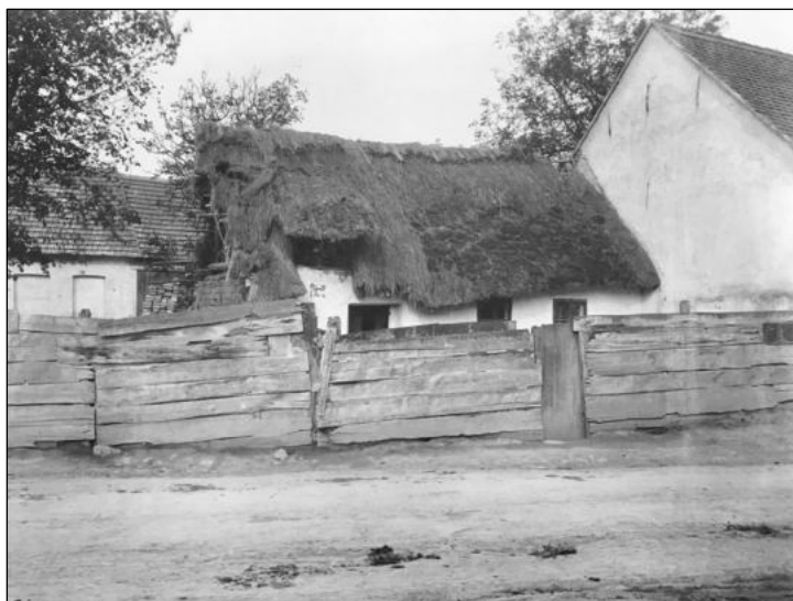
Obr. č. 11- Poslední došková chalupa rolníka z Židenic (zřejmě Stará osada č.9), zbořena v květnu 1913 [24]
