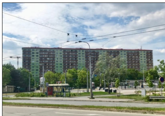
Obr. č. 46 - Panelový dům na Staré osadě č.o. 17-27 po regeneraci [vlastní]
