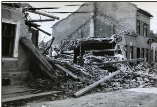
Obr. č. 25 - Vybombardované domy na ulici Rokycanova 23-27 [24]
