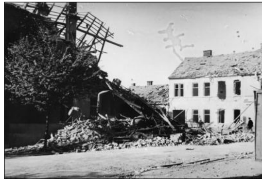
Obr. č. 26 - Vybombardované domy na ulici Rokycanova a Jílkova [24]
