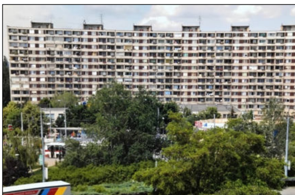
Obr. č. 45 - Panelový dům na Staré osadě č.o. 17-27 před regenerací [24]
