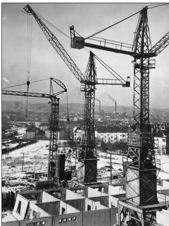
Obr. č. 37 - Výstavba sídliště Juliánov [24]
