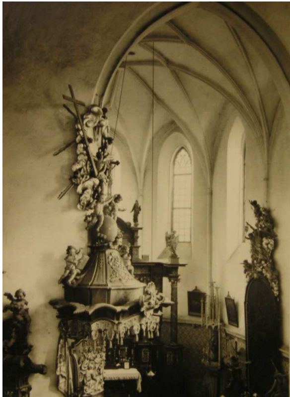
Obr. 4 - Pohled do presbytáře a na horní část kazatelny
