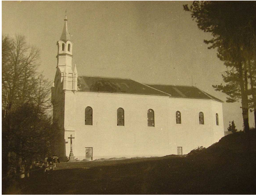
Obr. 9 – Montserrat v r. 1948, po opravě fasády
