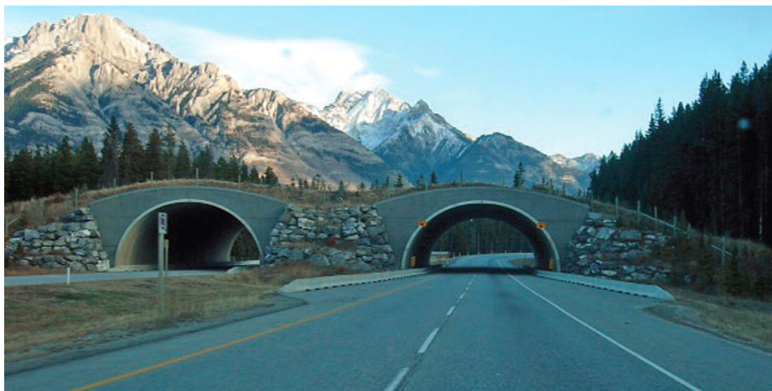
Obrázek č. 15 - Ukázkový ekodukt nad transkanadskou dálnicí (NP Banff) – bez světelného znečištění spojuje rozdělený les opět do jednoho celku, Zdroj: http://nika-casopis.cz
