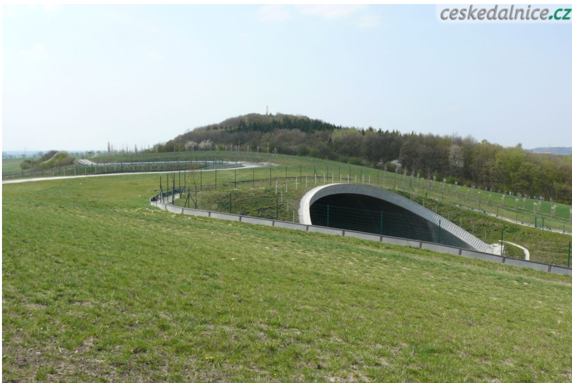
Obrázek č. 12 - Ekodukt Žehuň, D11, Horní část od jihu, 10.04.09, Zdroj: http://www.ceskedalnice.cz/dalnicni-sit/ekodukty/
