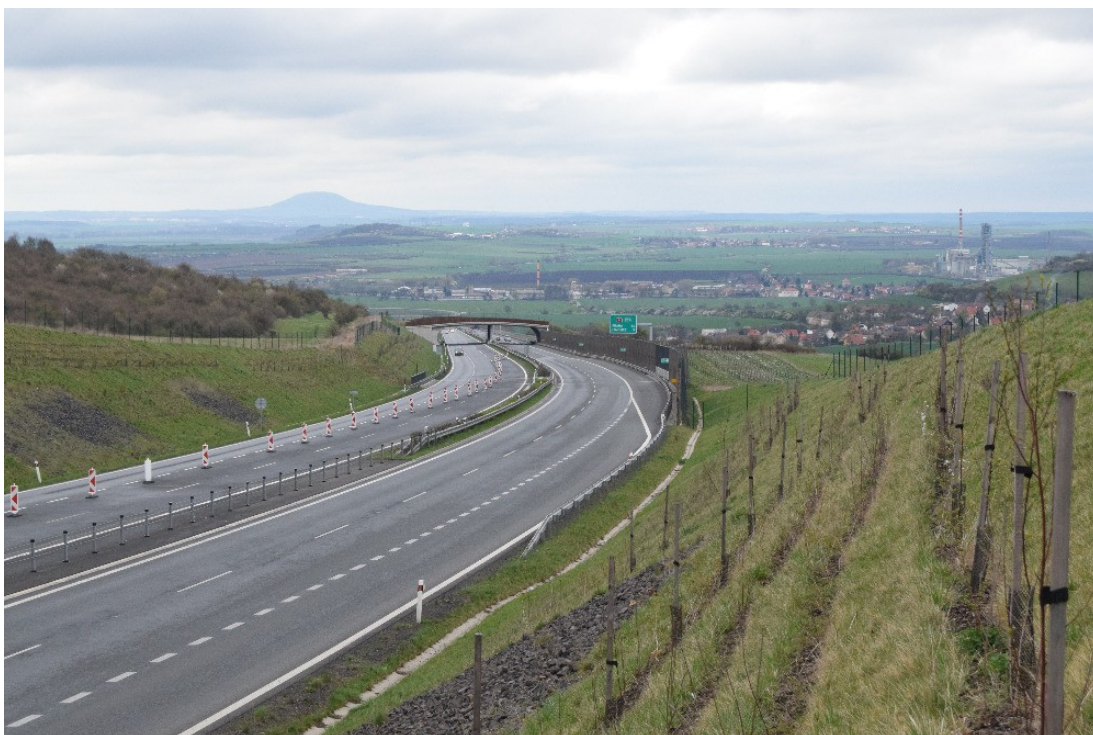
Obrázek č. 19 - Ekodukt Bílinka, D8, 50,935 km směr Praha, celkový pohled (Radek Rösner 2016)
