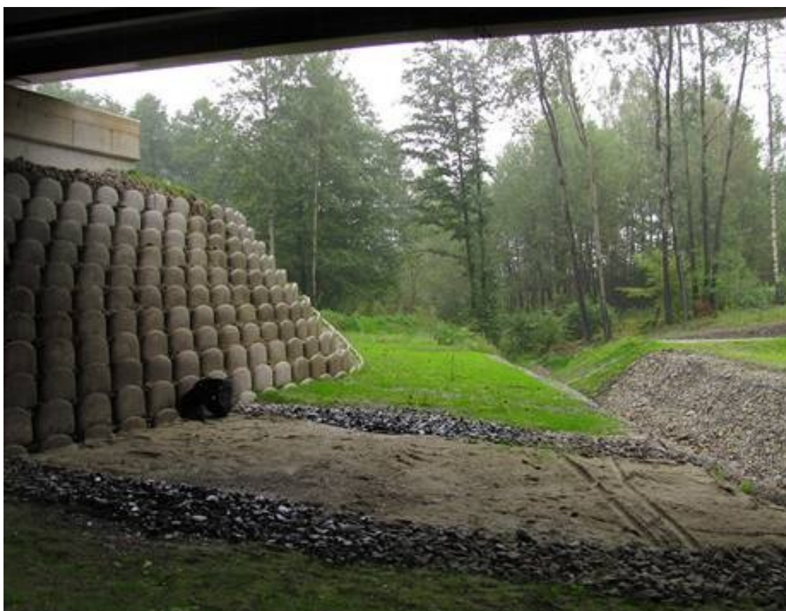
Obrázek č. 13 - podchod pod železniční tratí mezi Jablunkovem a Mosty u Jablunkova, Zdroj: http://www.zpravy.idnes.cz
