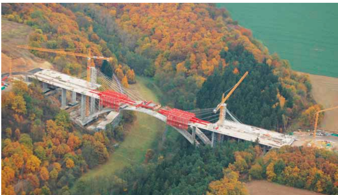
Obrázek č. 26 – Výstavba mostu přes Opárenské údolí na dálnici D8, Zdroj: RSD-paterni-sit-silnic-a-dalnic-v-cr
