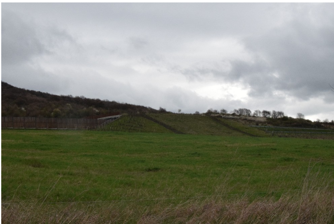
Obrázek č. 21 - Ekodukt Bílinka, D8, 50,935 km směr Praha, pohled na horní část (Radek Rösner 2016)
