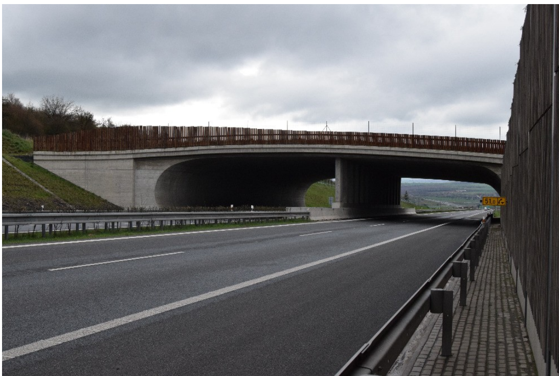
Obrázek č. 20 - Ekodukt Bílinka, D8, 50,935 km směr Praha, detailní pohled (Radek Rösner 2016)
