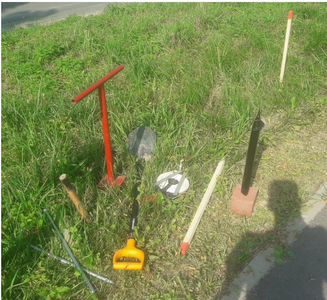
Obr. 5.2-1 Příprava na stabilizace bodu
