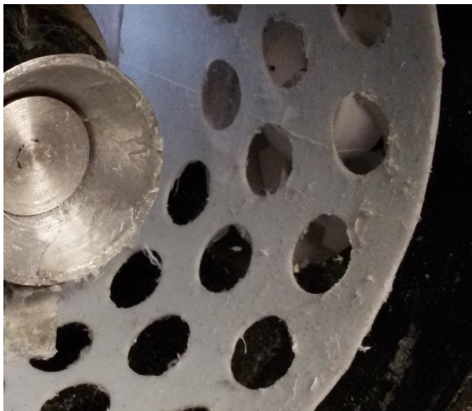
obr. 73: Ulpělé vrstvy na ploše vnitřního krytu, které jsou již oškrábané z čištění
