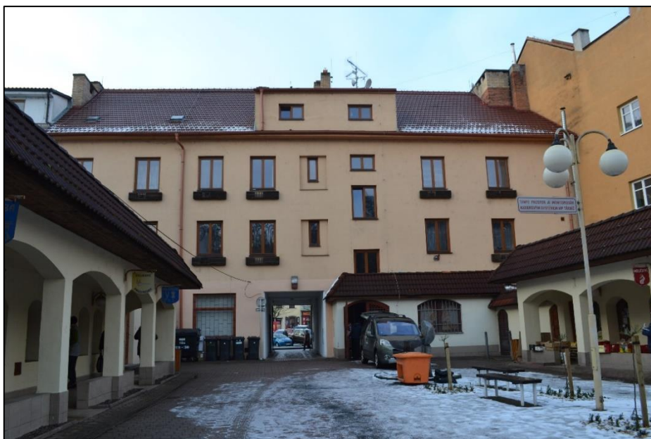
Obr. č. 16 – Pohled na oceňovanou budovu z dvorního traktu [vlastní]
