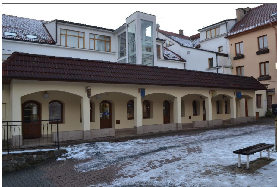
Obr. č. 17 – Pohled na pravou stranu krámků [vlastní]
