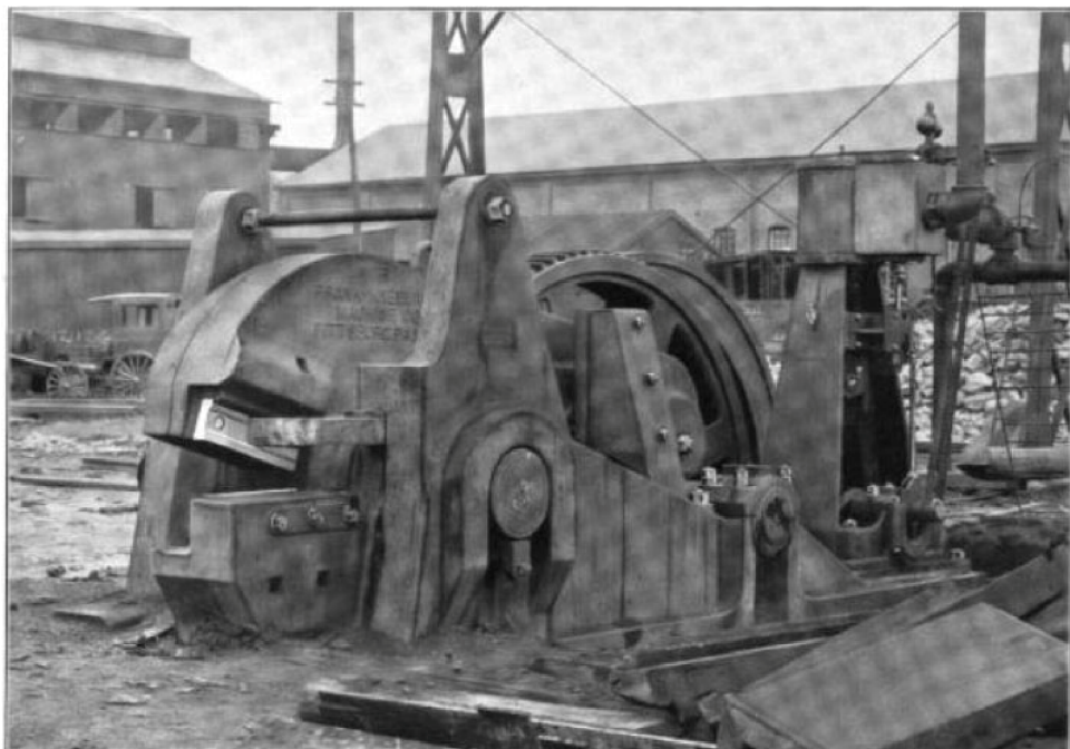
Obr. 6 - Mechanické, tzv. aligátorové nůžky pro stříhání ocelových profilů [5]
