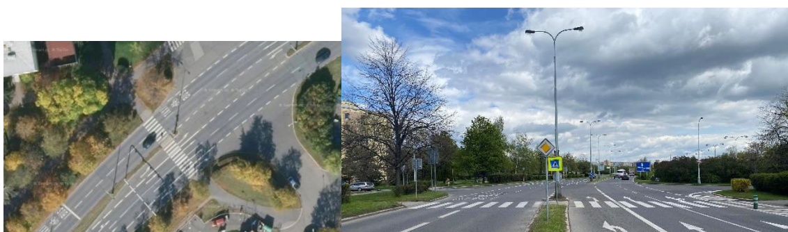
Obrázek 17 - ul. Opatovská před a po rekonstrukci
