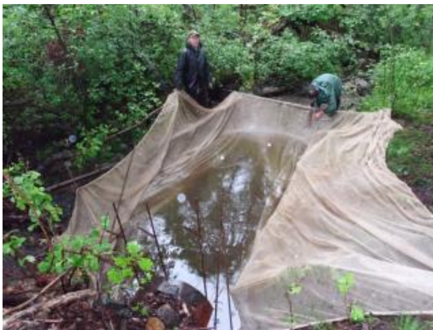
Obr.2 - Instalace podložní sítě pod hrází rybníka Rohlíček
