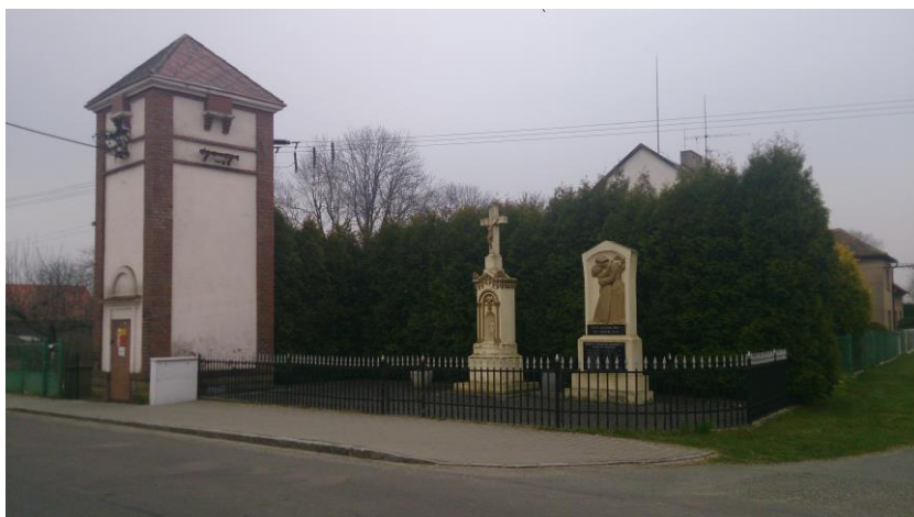
Obrázek č.: 5 Zděná trafostanice, Památník padlým a kamenný kříž (zdroj: vlastní)
