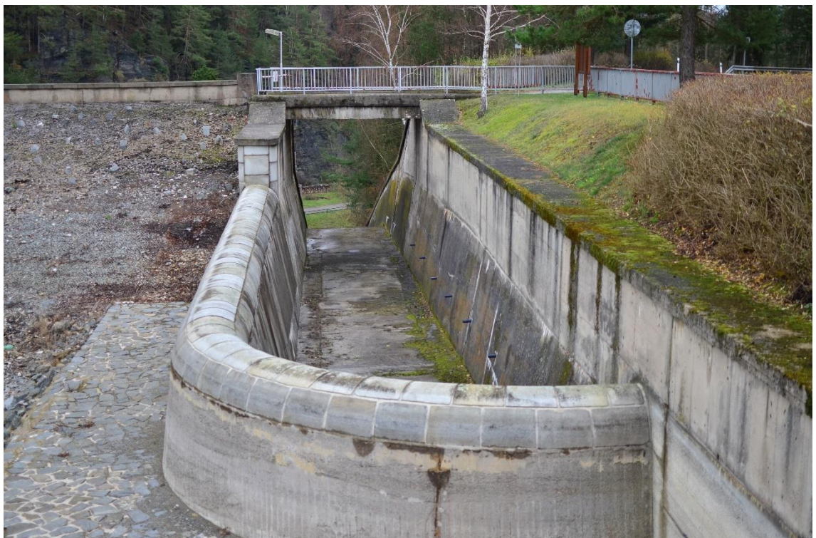
Obrázek 9 Bezpečnostní přeliv VD Letovice, pohled z lávky odběrné věže
