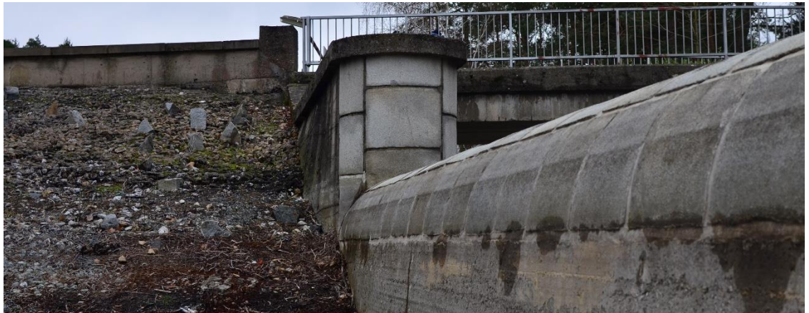
Obrázek 8 Opevnění přlivné hrany kamennými bloky
