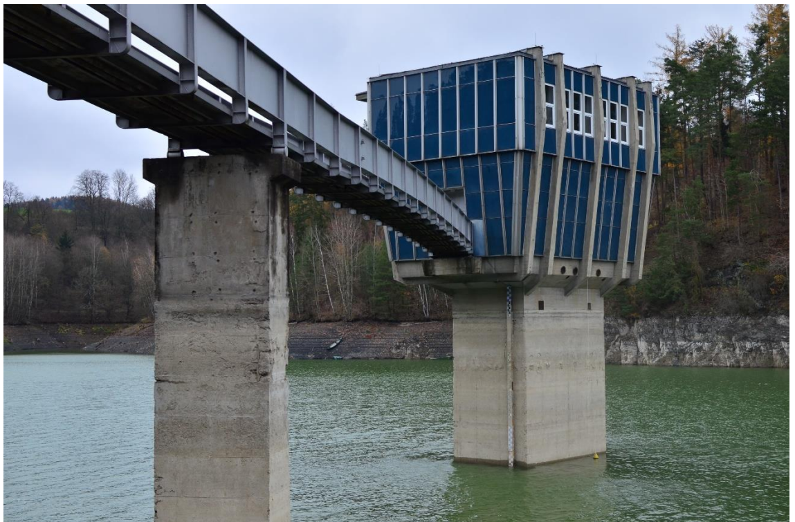
Obrázek 10 Odběrná věž s lávkou, pohled z pravého břehu
