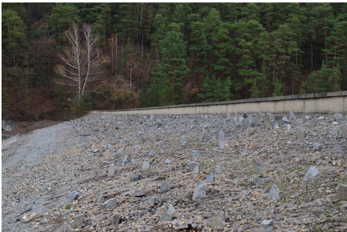
Obrázek 7 Pohled na návodní líc hráze z pravého břehu
