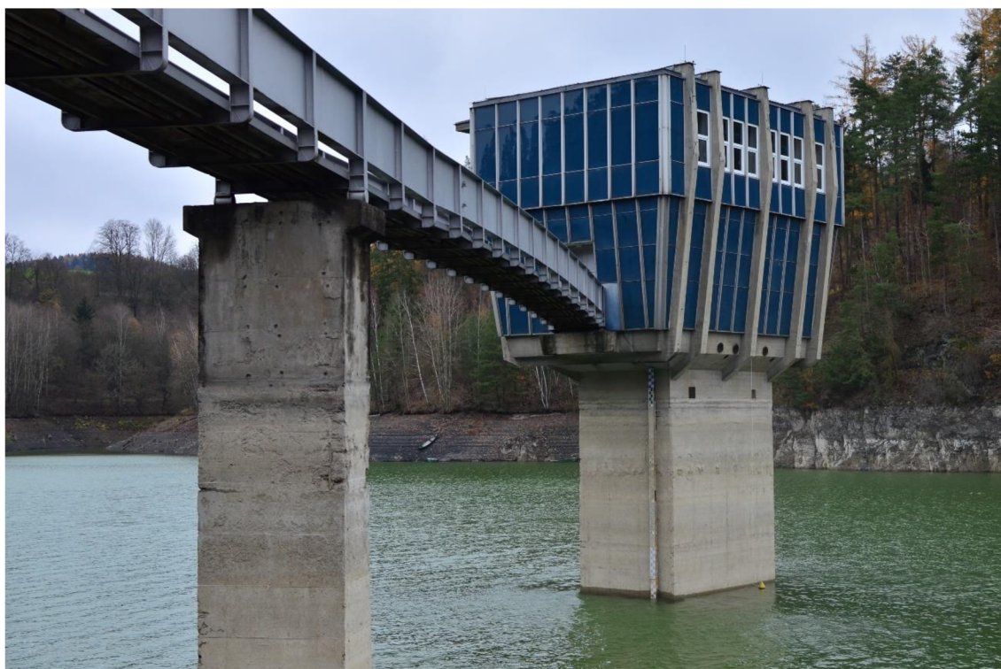
Obrázek 10 Odběrná věž s lávkou, pohled z prvního břehu
