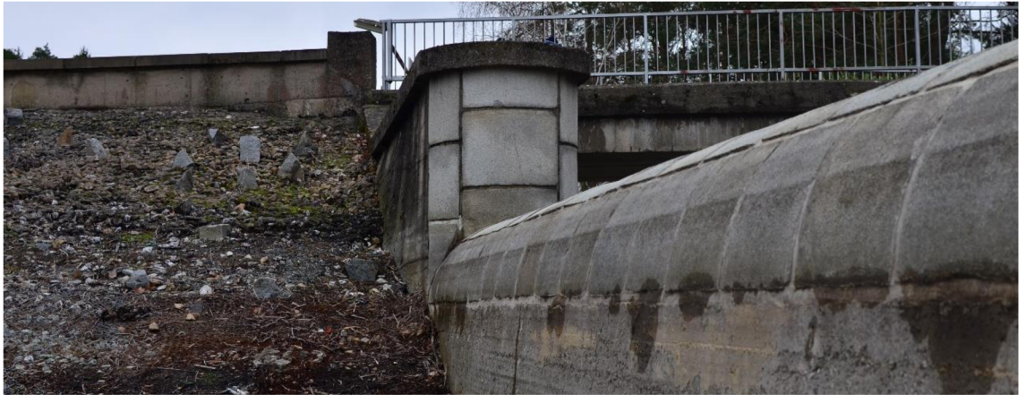
Obrázek 8 Opevnění přelivné hrany kamennými bloky
