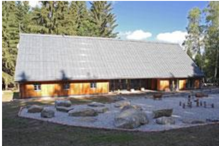
Obr. 3: Budova Návštěvnického centra Srní - zdroj: Návštěvnické centrum Srní NP Šumava.
