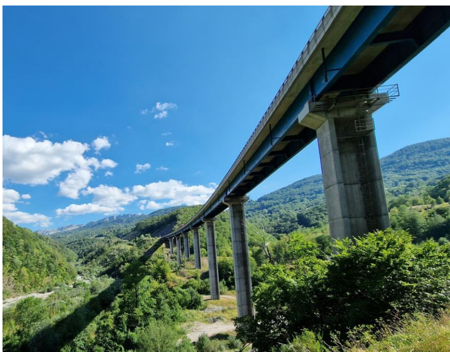
Obrázek č. 20 Viadukt v Bosně a Hercegovině
