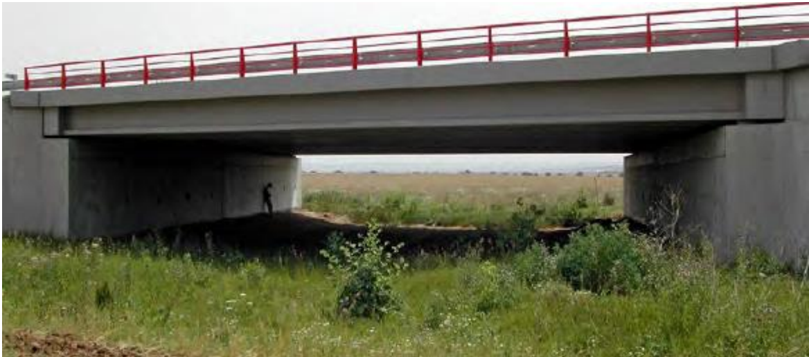
Obrázek č. 18 Speciální most vybudovaný výhradně k migraci živočichů. Vhodné by bylo doplnit jej o naváděcí zeleň a protihlukové stěny (© archiv AOPK ČR) Zdroj: Hlaváč et al. 2020
