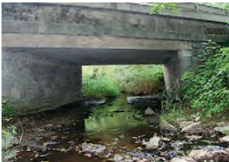
Obrázek č. 13 Mostek s přirozeným korytem a suchým břehem Zdroj: Hlaváč et al. 2017
