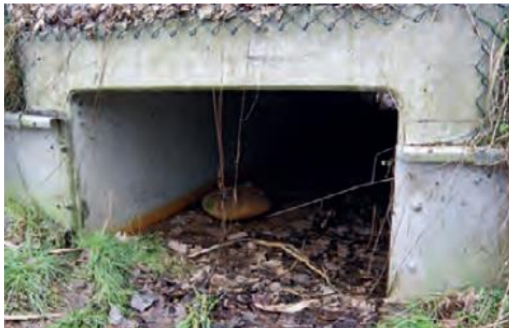
Obrázek č. 12 Vhodný propustek s přirozeným dnem. Zdroj: Anděl et al. 2017
