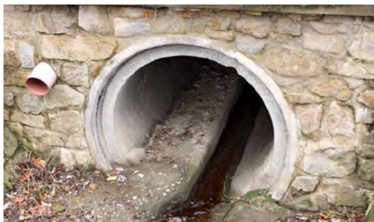
Obrázek č. 10 Upravený trubní propustek pro průchod vodních i suchozemských živočichů (@Václav Hlaváč) Zdroj: Hlaváč et al. 2020
