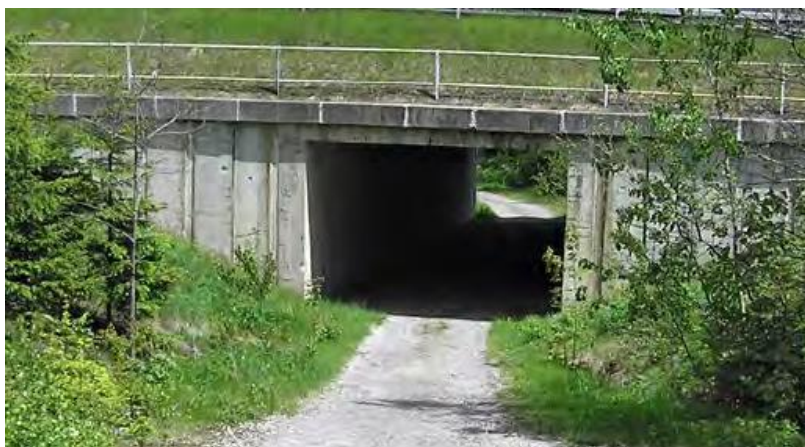
Obrázek č. 16 Parametry tohoto podchodu jsou nedostatečné pro velké a středně velké savce. V případě rekonstrukce by bylo vhodné most rozšířit na šířku alespoň 10-20 m. (© Václav Hlaváč) Zdroj: Hlaváč et al. (2020)
