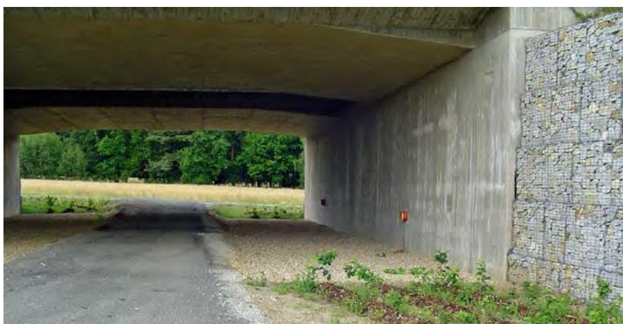
Obrázek č. 17 Optimalizovaný podchod přes účelovou komunikaci představuje obvykle plně funkční podchod pro živočichy do velikosti srnce a prasete divokého, za optimálních podmínek může být využit i velkými šelmami, jelenem nebo losem. (© Jana Kloubcová) Zdroj: Hlaváč et al. 2020
