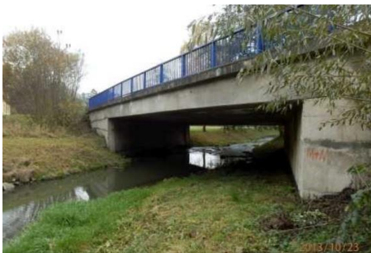
Obrázek č. 14 Most Letovice - ideální řešení je ponechání vodního toku v co nejpřirozenějším stavu a suché cesty podél toku. Zdroj: Správa a údržba silnic Jihomoravského kraje
