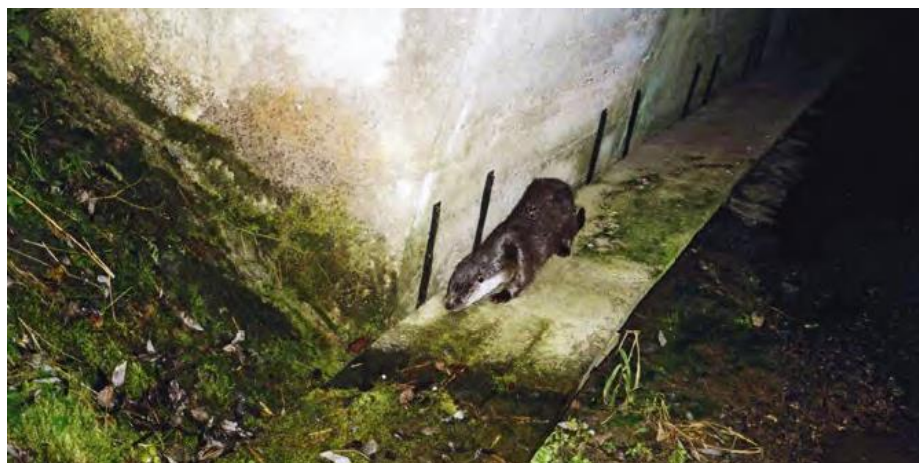
Obrázek č. 15 Vybudovaná lávka pro suchozemské živočichy. (©Václav Hlaváč) Zdroj: Hlaváč et al. 2020
