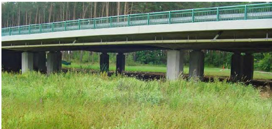
Obrázek č. 19 Estakáda na dálnici D3 u obce Žišov byla vybudována pro překování mokřadů a tůní s výskytem piskoře pruhované (© Jana Kloubcová)
