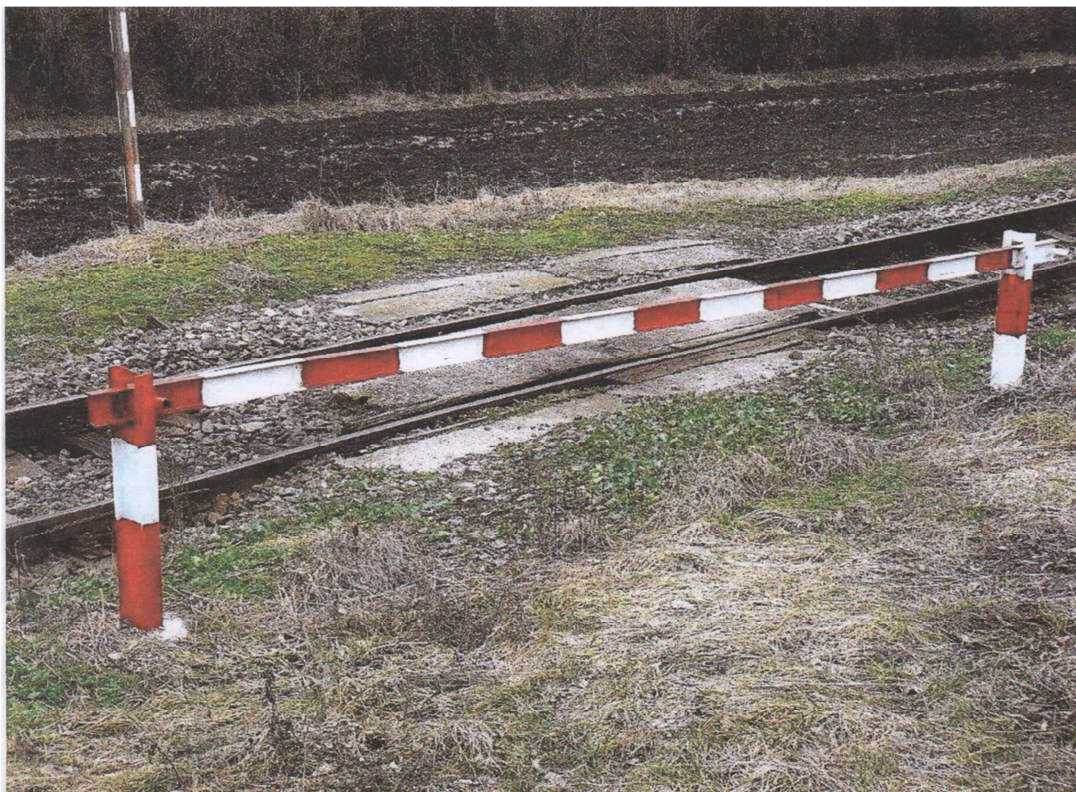
Obr. č. 6 – Uzamykatelná zábrana [14]
