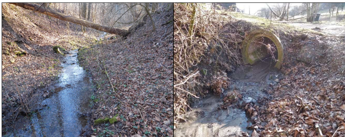
Obr. 11. Vodní tok VT1 v lesní trati (vlevo), výtok z kanalizace DN 800 do VT1 (vpravo)
