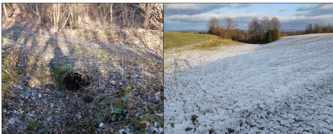
Obr. 17. Závěrový profil (ZP3) na vtoku do propustku DN 600 (vlevo), sběrné povodí P3 (vpravo)
