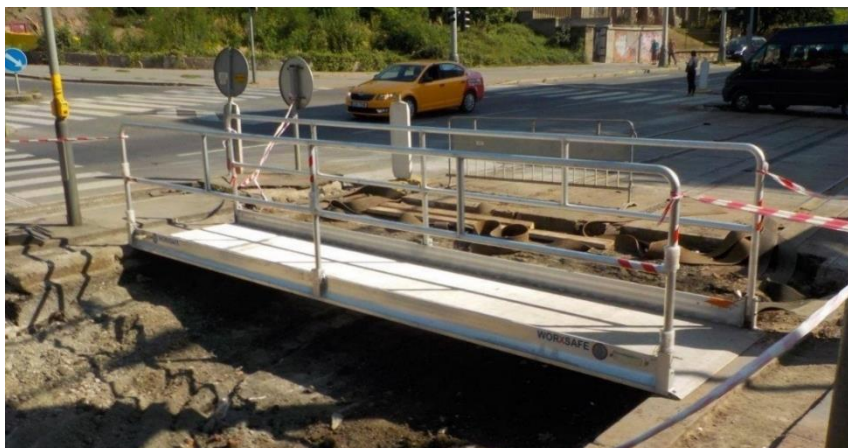
Obrázek 7.39: Přechodová ocelová lávka [25]
