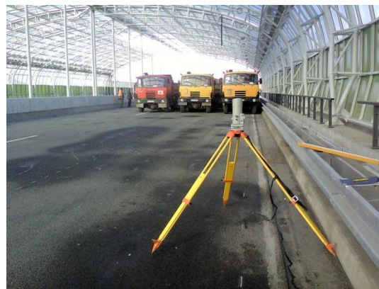
Obrázek 2.10 – Zatěžovací zkouška mostu – nivelace z místa na konstrukci [46]
