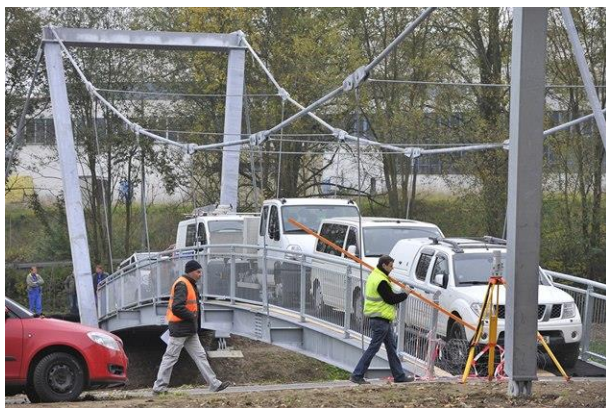
Obrázek 2.9 – Zatěžovací zkouška lávky – nivelace z místa mimo deformovanou oblast [45]
