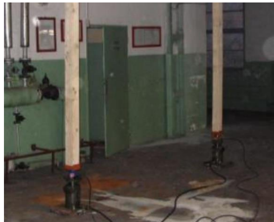
Obrázek 1.9 – Zatěžování stropní konstrukce in situ pomocí hydraulických lisů [27]
