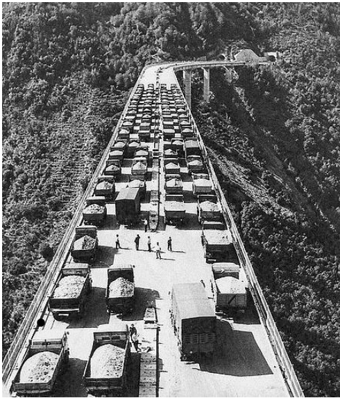
Obrázek 1.1 – zatěžovací zkouška in situ Sfalassa bridge – bez dosažení meze únosnosti [29]
