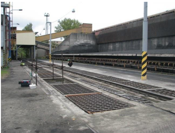
Obrázek 3.3 – Hlubinný zásobník uhlí – horní pohled na nosný železobetonový rošt
