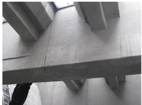
Obrázek 3.4 – Pohled ze spodní strany na nosný rošt po sanaci – podélná žebra, příčný průvlak a dělicí stěna
