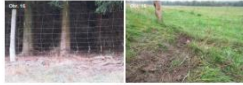
Obr. 15: Dvalet oplocení, slabe místo – částečné postavení a uzavřený plot, pro šelmu možná pohled (Foto: P. Kuneš). Obr. 16: Detail oplocení a místa podhrabání (Foto: P. Lupaš)
