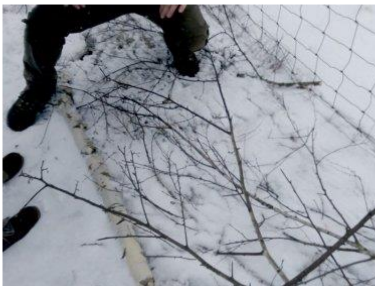
Obrázek 15 Ochrana proti podhrabání, Zdroj AOPK ČR 2023
