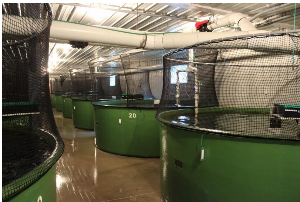
Obrázek 5: Zařízení rybí líhně AquaBounty v Kanadě (Waltz, 2016)
