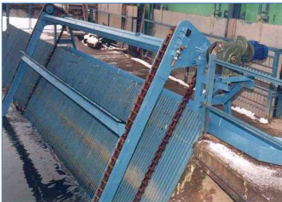
Obrázek 3: Strojně stírané česle řetězové [8]
