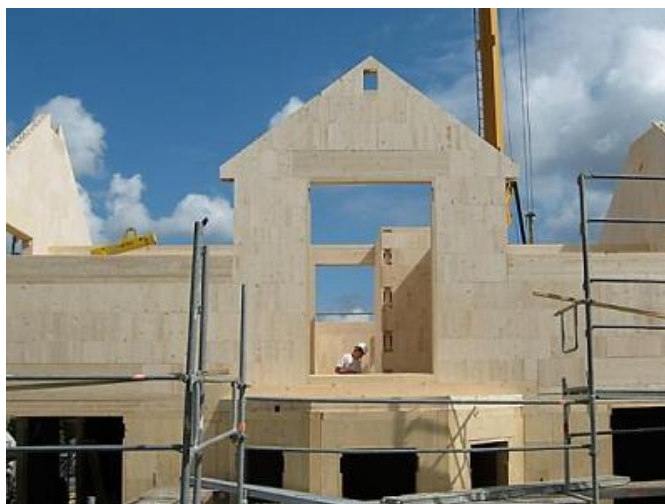
Obrázek 15: Masivní konstrukce dřevostavby (zdroj: KODEX REALITY s.r.o. 2020)
