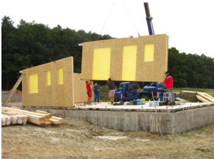
Obrázek 11: Panelová konstrukce – montáž na staveništi (zdroj: KODEX REALITY s.r.o. 2020)
