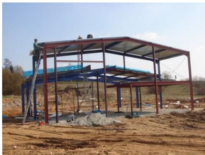
Obrázek 4 Hala Aldo metal zdroj: Aldo metal s.r.o
